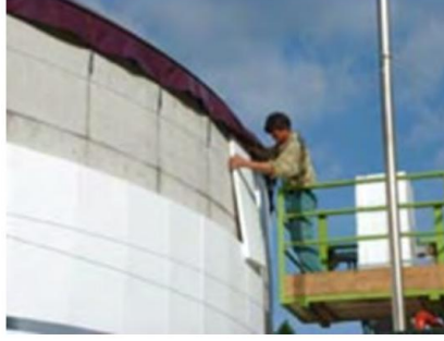
अंजीर. 17. इन्सुलेशन स्थापित करणे (BIOGAS NORD GmbH)
