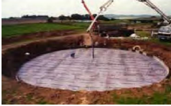
अंजीर 9. व्यावसायिक बायोगॅस प्लांटसाठी काँक्रीटचे मिश्रण ओतणे (BIOGAS NORD GmbH)
